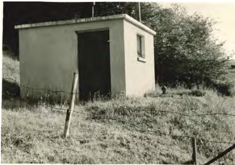
Der kleine Bau, der 1956 errichteten Pump- und Filteranlage in Hofacker .
